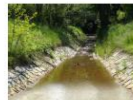
Pohled proti proudu na koryto Halounského potoka pod kritickým bodem (propustek pod komunikací Řevnická ul.)
