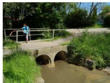
Propustek přes koryto Halounského potoka
